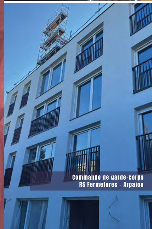
Réalisation et pose de garde-corps portillier et rampe d'escalier pour une crèche - Pierrefitte-sur-Seine
